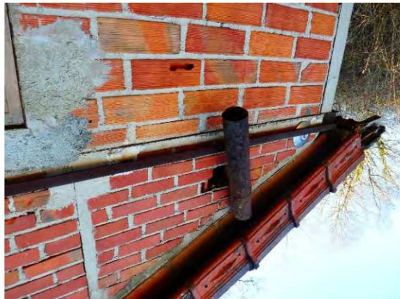
Photo 77 : Bâtiments avec gîtes potentiels à chiroptères, in situ (Sce : IEA)
